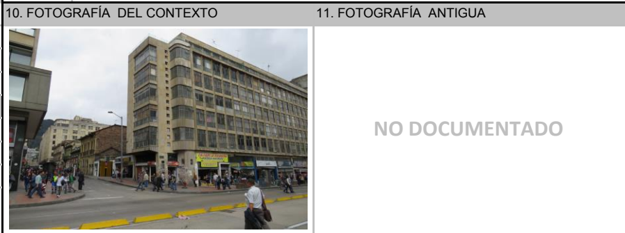
Fuente: Equipo Fotografía PEMP Patrimonio Inmueble Fuente: No documentado
