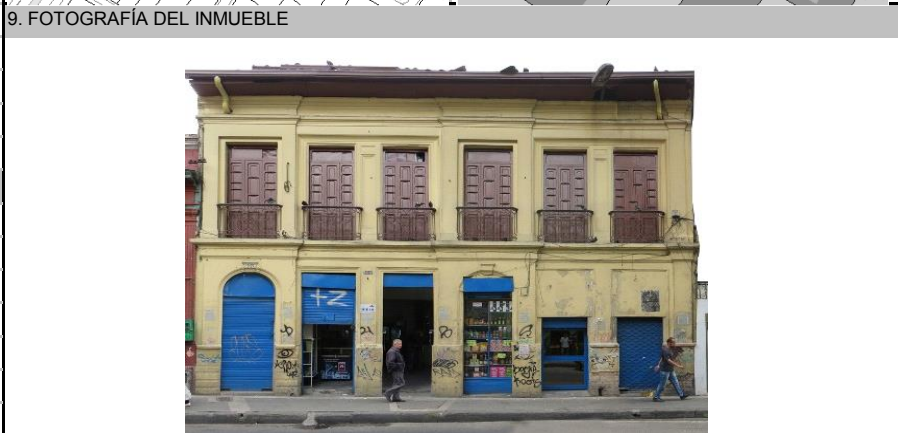
Fuente: Equipo Fotografía PEMP Patrimonio Inmueble
